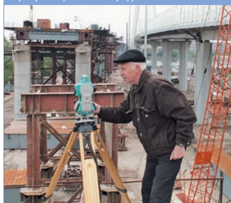
Разбивочные работы на строительстве Большого Обуховского вантового моста через р. Неву в С.-Петербурге
