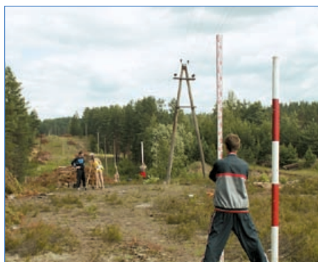
Разбивка и нивелирование трассы
