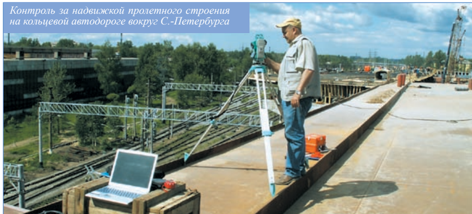
Разбивочные работы на строительстве Большого Обуховского вантового моста через р. Неву в С.-Петербурге
