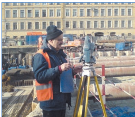
Геодезический мониторинг строительства 2-й сцены Мариинского театра в С.-Петербурге с использованием тахеометра Sokkia SET IX
