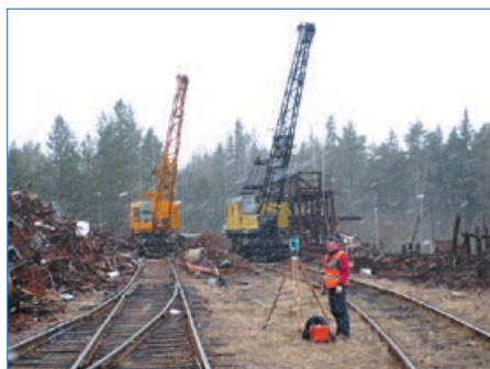
Фото 1. Съемка железнодорожных путей электронным тахеометром.
